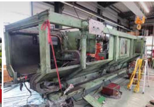
Demontage und Retrofit
